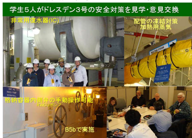
図4 派遣した5人の学生がドレスデン3号を見学 整備された非常用復水器（IC）や凍結防止対策、 B5bで格納容器内の弁を手動操作可能、意見交換
