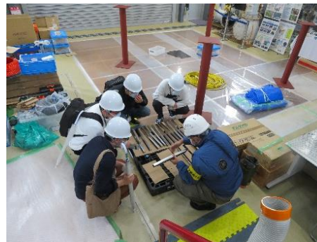
金属の切断面を確認
