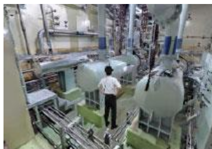
解体手順の合理化検証
