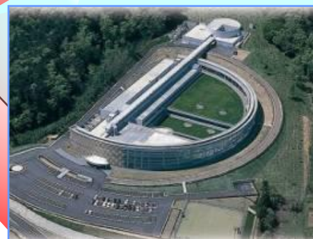
若狭湾エネルギー研究センター
