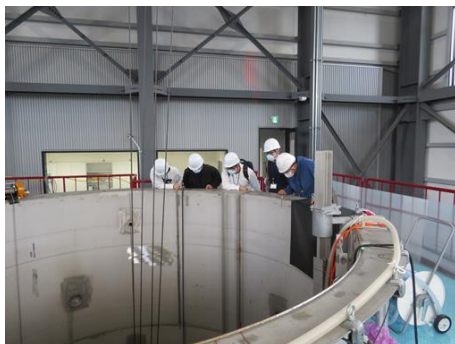
粉じん量をモックアップ施設で確認
