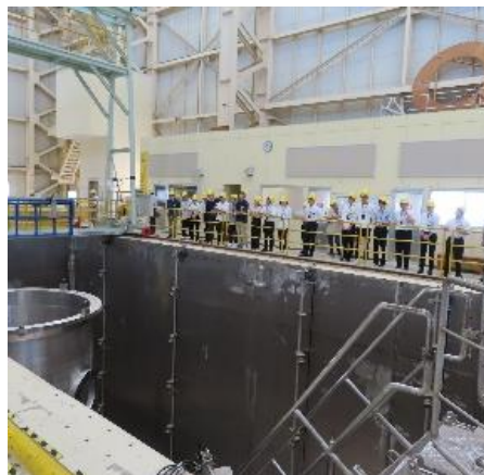
[現場見学] 保全訓練設備
