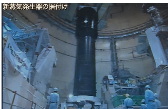
【座学】 蒸気発生器の取替
