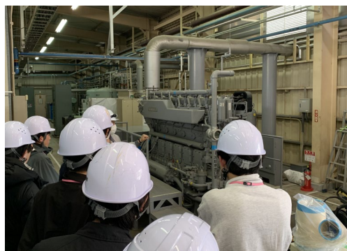
図 3.3-36 研究炉 (NSRR) 施設見学②
