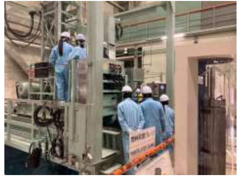
図 3.2-17 燃料取替作業
